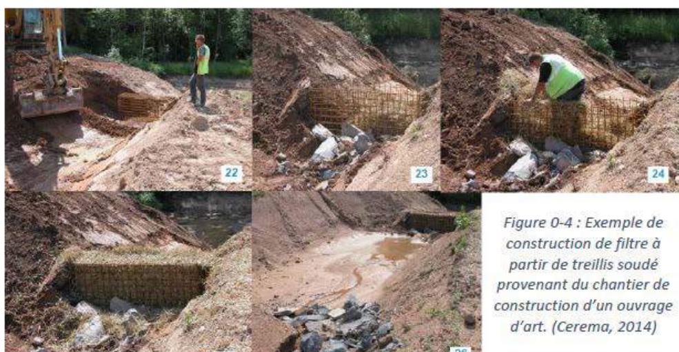
22 - Réalisation d'une « cage » ouvrable en treillis soudé, ouverture sur le dessus, et creusement du bassin en amont 23 - Dispositif de filtration positionné de manière à empêcher le passage d'eau en dessous ou à côté, et blocage du dispositif par des blocs pour qu'il ne soit pas emporté par la pression des eaux 24 - Mise en place de paille compactée par piétinement 25 - Dispositif prêt à fonctionner 26 - Dispositif en fonctionnement sur le chantier
